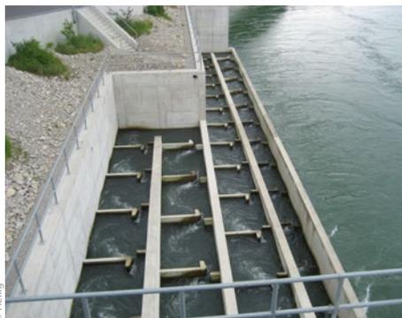
Bild 1: Ökopunktfähiger Schlitzpass
