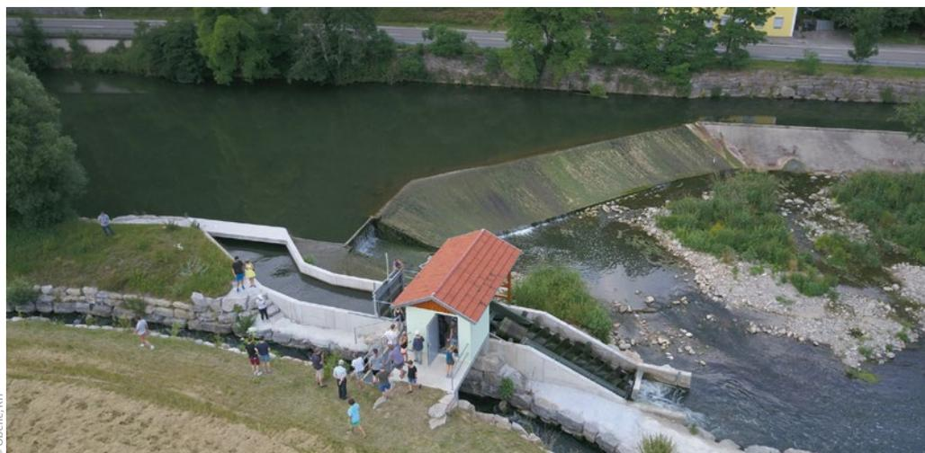
**Bild 4:** Restwasserturbine
